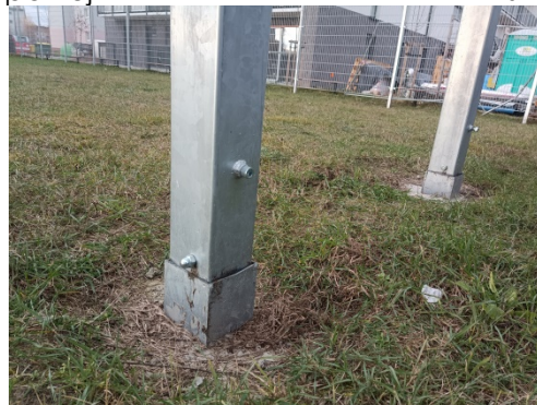
Fot. 2 Kosz do koszykówki – sposób posadowienia
